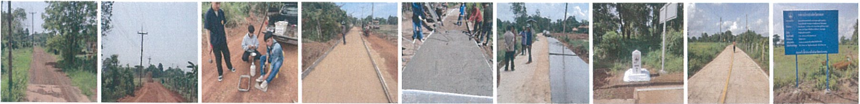
23. โครงการก่อสร้างถนนคอนกรีตเสริมเหล็กสายบ้านชุมชนหนองมันปลา เขตเทศบาลนครสกลนคร – บ้านนาแก หมู่ที่ 4 ตำบลดงมะไฟ อำเภอเมืองสกลนคร จังหวัดสกลนคร
